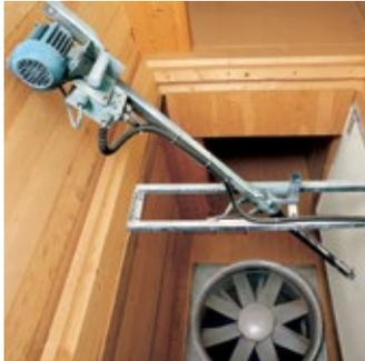
Frischluftöffnung in der Außenwand des Lagers, sodass bei Umluftbetrieb nur Innenluft durch das Lagergut geführt wird. Über einen Industrie-Spindelmotor mit selbsthemmendem Schneckengetriebe steuert der Gaugele-Regler die Klappenstellung und sorgt damit für das notwendige Mischungsverhältnis von Innen- und Außenluft.
